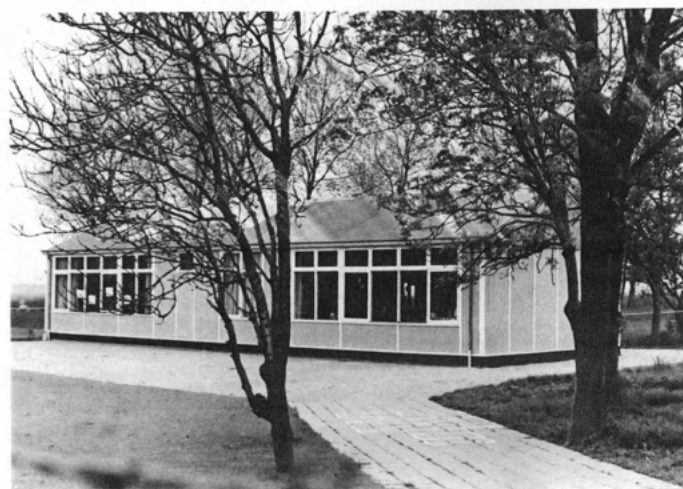
Het houten schoolgebouw aan de Weteringlaan in Oude Wetering, in de bouwtekening van gemeentewerken omschreven als 'openbare lagere schoolbarak'.
